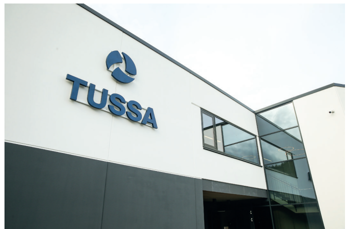
Bygget er bygget med betongelementer fra Spenncon, produsert i nabobygda Hjørungavåg. Fasaden er malte betongelementer.
