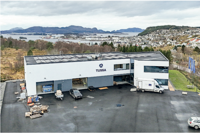
Det nye bygget til Tussa Installasjon sett fra inngangspartiet mot vest. Her ser vi hvor bygget ligger i forhold til Ulsteinvik sentrum. Lagerdelen til venstre, administrasjonsdelen til høyre.
