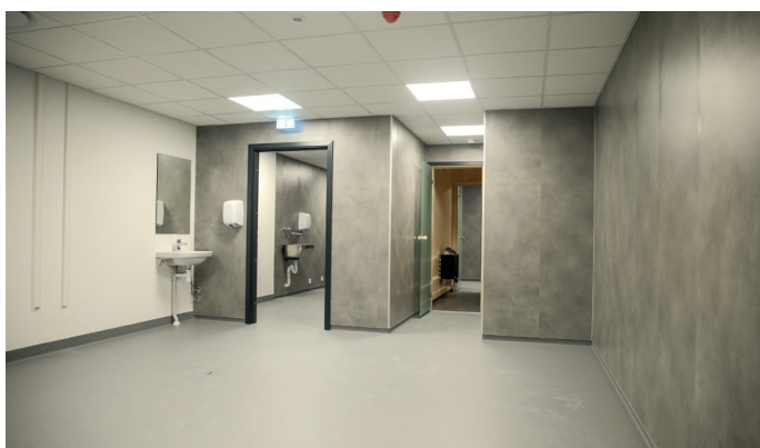
En av garderobene i bygget med inngang til sauna. Vi ser her er belegg på gulv, våtromsplater på vegger og systemhimling.
