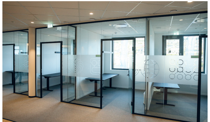
Fra kontordelen i bygget. Vi ser kontorene er inndelt med systemglass-vegger. Her er teppeflis på gulv og systemhimling.
